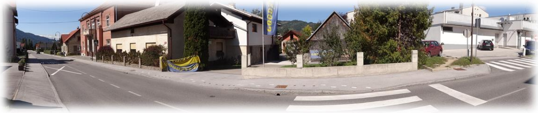
Fotografija 7 (prehod za pešce pri »glasbeni šoli« na Falski cesti)
